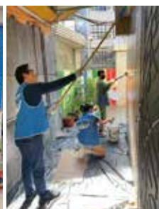
▲華茂扶輪社社服 施工牆壁防水
